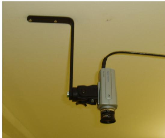
Abbildung A.1: Kamera mit Montagewinkel zur Befestigung an der Decke
